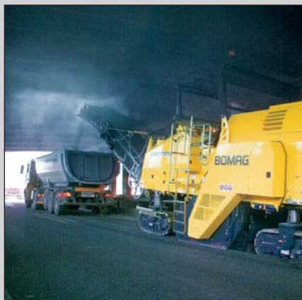
Per lavorare con precisione nei tunnel in condizioni di spazio ridotto.
