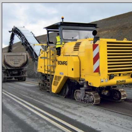
Elevata produttività nel risanamento a strati delle strade statali.
